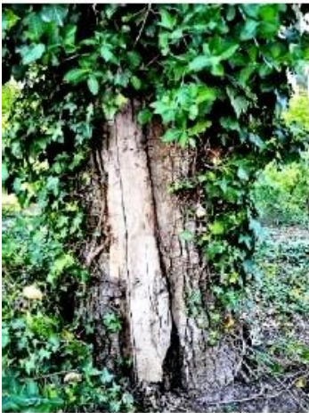
Beispiel 4: Baum mit starkem Efeubewuchs, nicht kontrollierbar: intensive, visuelle Baumkontrolle durchführen
